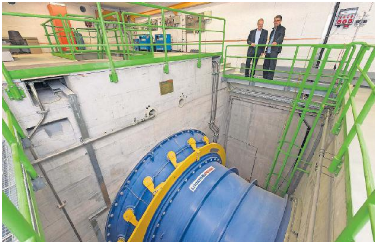
Rolf Mathis von der Axpo und Christoph Tandler, Projektleiter, stehen im Dotierkraftwerk und schauen in den neuen Turbinenschacht.
